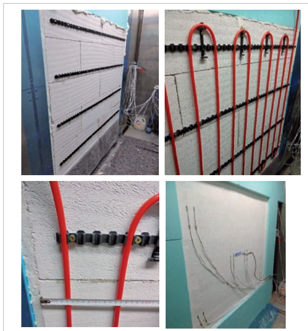
Obr. 4 Stena s rúrkami vo vnútornej omietke – pohľad z interiérovej komory
