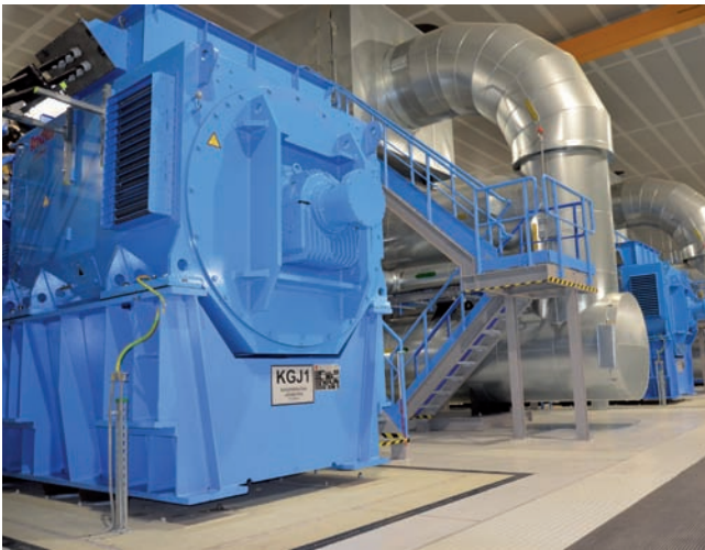
Nové kogeneračné jednotky v Martinskej teplárenskej, a. s., člena skupiny MH Teplárenský holding
